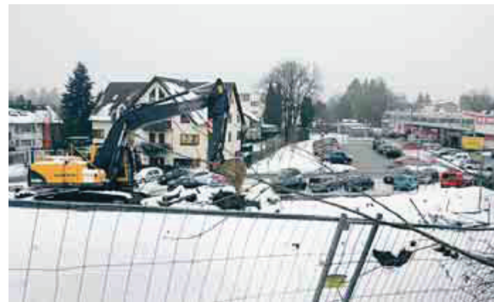
Die Erdarbeiten für den Neubau haben bereits begonnen. BILD: NEUMANN
